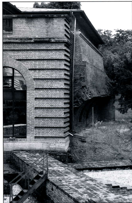
■ 4. kép: Kiépítés előtt lévő csapadékvíz-elvezetés a szegedi vártemplom ásatási területén ■ Photo 4. Rainwater evacuation system under construction at the excavation site of the fortified church in Szeged
