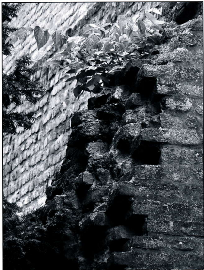
■ 17. kép: Előtérben az eredeti védtelen fal, háttérben a légpórusos hidrofóbhabarccsal kifugázott felület
