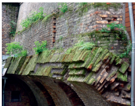
Csapadékvíz lefolyásában korlátozott korabeli falazat felületi védelem nélkül a szegedi vár falánál
