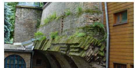
Előtérben az eredeti, védtelen fal, a háttérben a légpórusos, hidrofób habarccsal kifugázott felület
