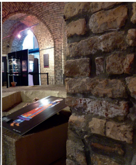
A kiállítási körülményekre kevésbé érzékeny csőrévészeti kiállítás a szigeteteletlen szegedi várban, amelynek falán sókiválások láthatók
