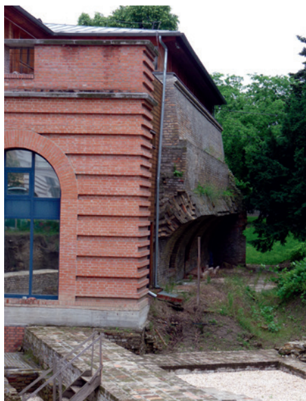
Kiépítés előtt lévő csapadékvíz-elvezetés a szegedi vártemplom ásatási területén
