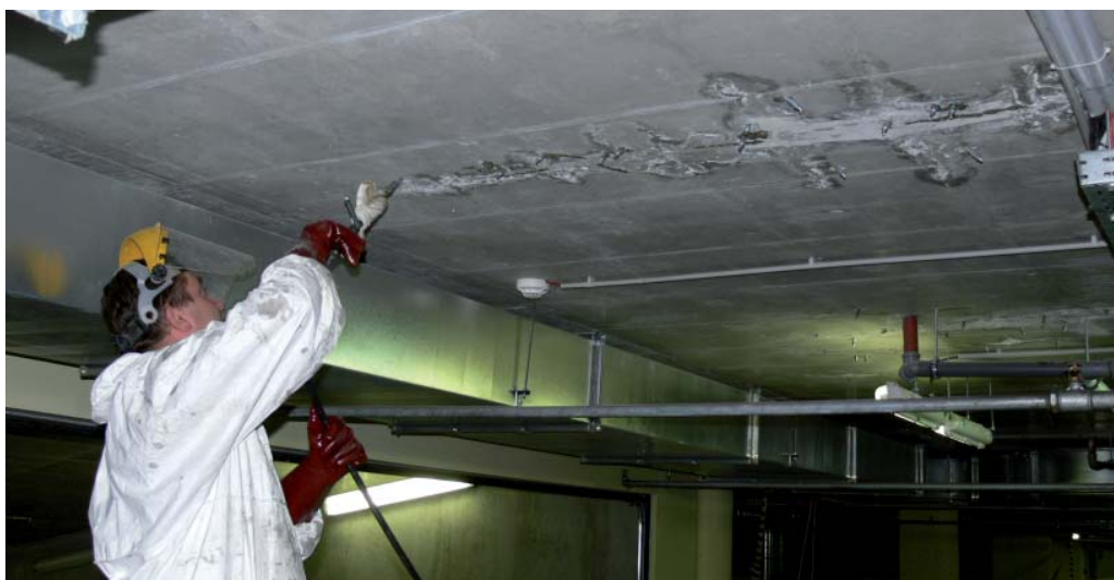
Vasbeton födém repedésének injektálása poliuretángyantával
