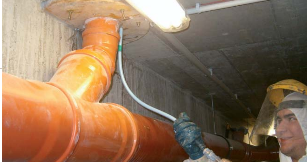
Vízvezető csőátvezetés injektálása
