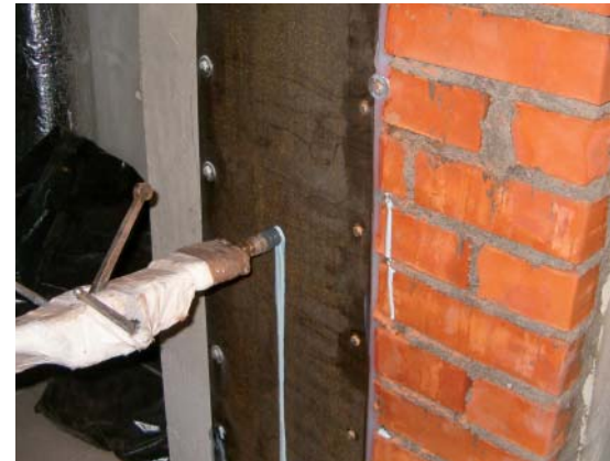
Acéllemezzel lezárt dilatációs hézag injektálása 1. kép
