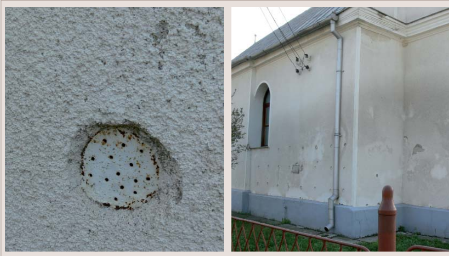
Fugyvásárhelyi református templom „falszárítási” módszere
