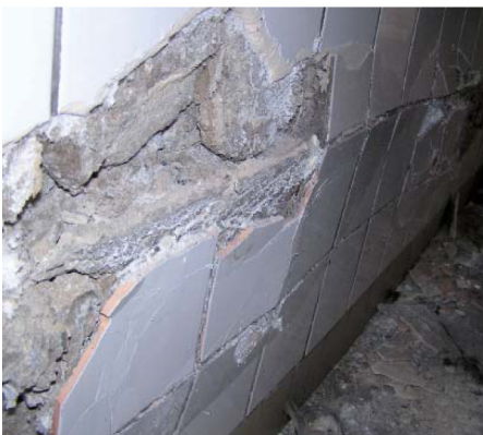
A csempeburkolatot roncsoló kristályosodási folyamat
