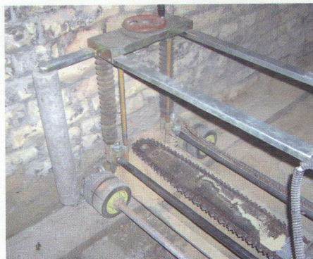
Falvágás önjáró kardlapos falvágógéppel
