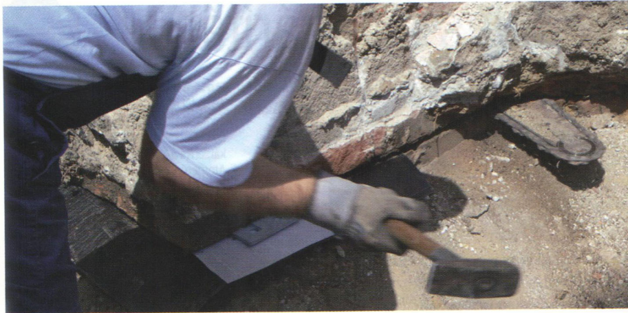
A falazat kiékelése műanyag ékekkel
