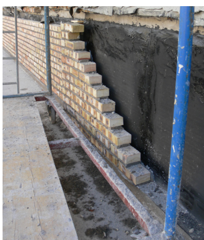
Bitumenes lemez lábazatszigetelés visszavésett téglafelületen
