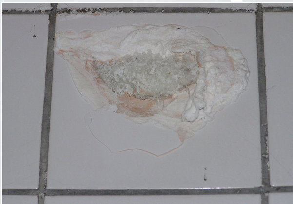
A hagyományos habarcsrétegbe ágyazott csempeburkolat mögötti részben kikristályosodó tús sókristályok átszúrták a csempeburkolatot is
