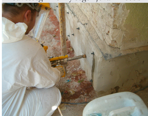
Akrilát gél lábazati tömbinjektálás falvágásos vízszintes falszigetelés síkja alatt
