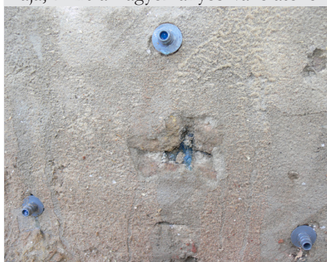
Akrilát gél lábazati tömbinjektálás falvágásos vízszintes falszigetelés síkja alatt
